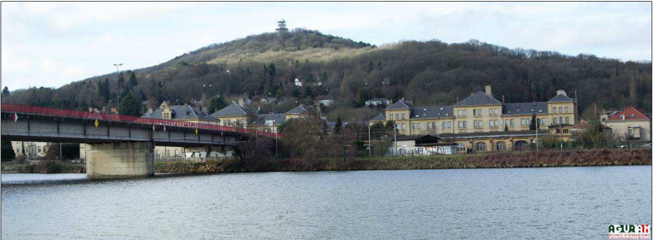
Vue en direction du site de projet depuis Longeville-lès-Metz depuis le parc du Grand Pâtural
